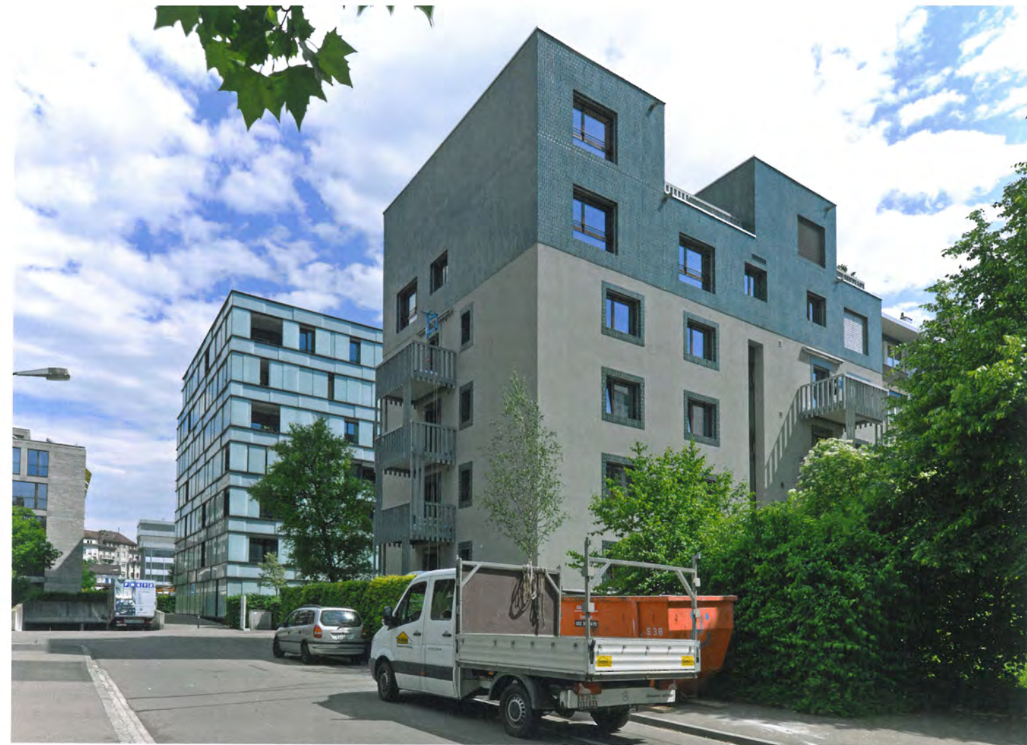
Die Transformation des Neuwiesenquartiers wird von umfassenden, infrastrukturellen und baulichen Massnahmen getragen. Dazu gehören das Bauen in die Höhe sowie die Sanierung der alten Gebäudehüllen.
