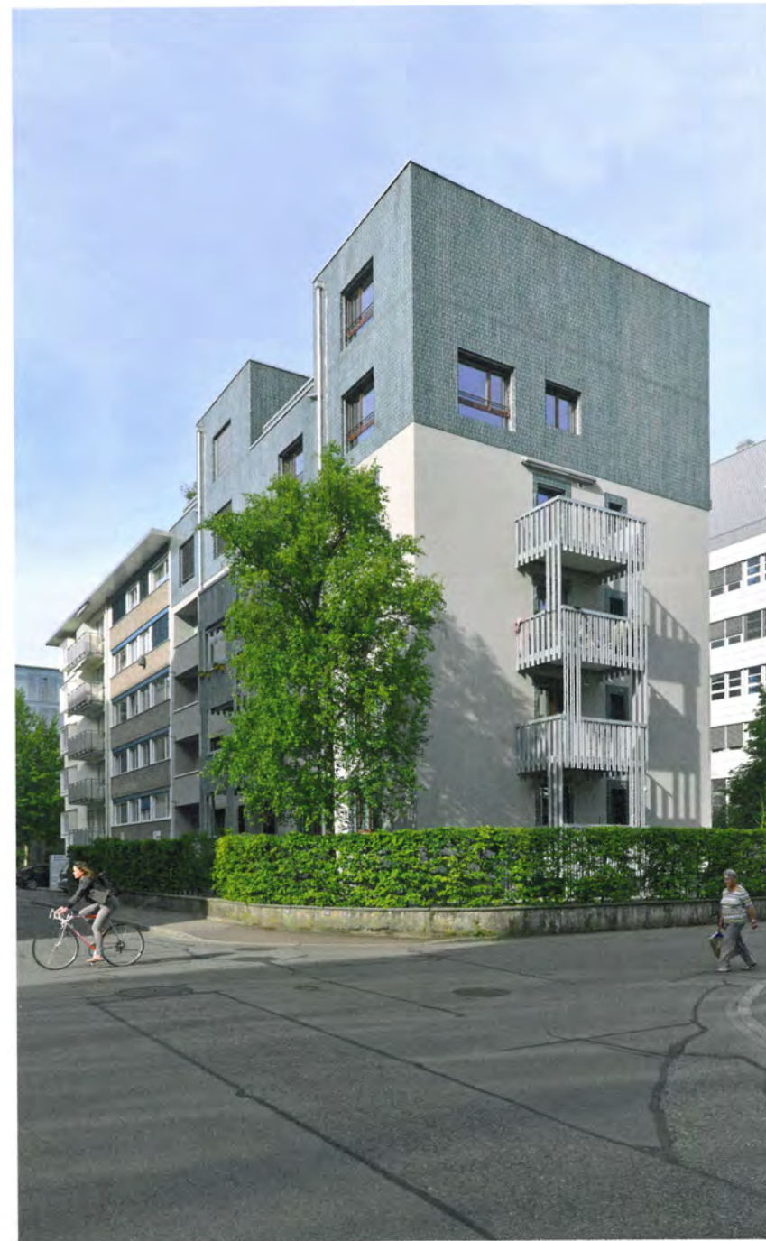
Die zinnenartige, holzbauliche Aufstockung spiegelt ebenso wie die eleganten Oberflächen und die das Gebäude strukturierenden, neuen Balkone den hochwertigen Leitgedanken der Baumassnahme wider.
