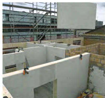
Während der Erschliessungskern gemauert wurde (rechts), besteht der Rest der Aufstockung aus Holz.
