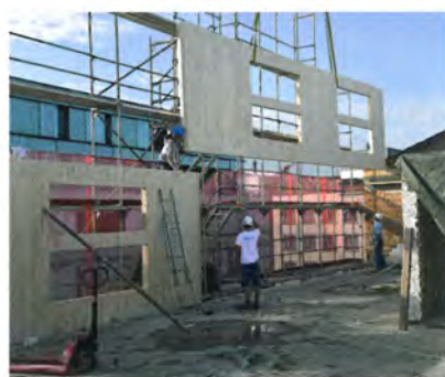
Die gesamte Sanierung und Aufstockung erfolgte im bewohnten Zustand. Wie gut, dass der moderne, elementbasierte Holzbau vergleichsweise leise und staubfrei erfolgen kann.
