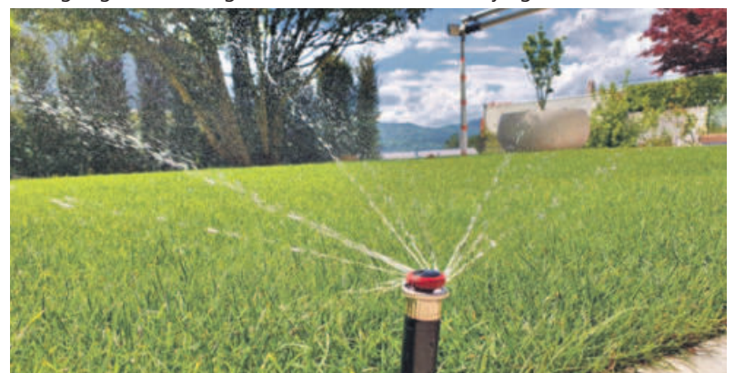
Bewässerung zielgenau dort, wo sie notwendig ist.
