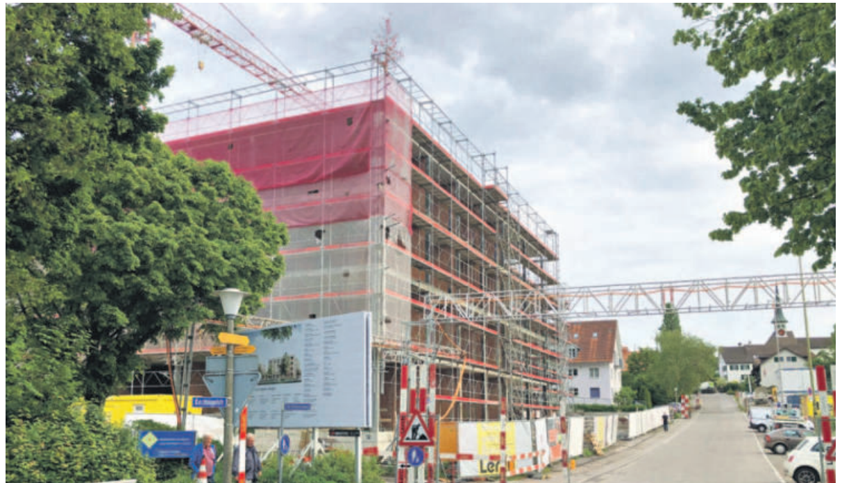
Der Rohbau vom Haus Feld ist erstellt und kann im September 2022 in Betrieb genommen werden.
